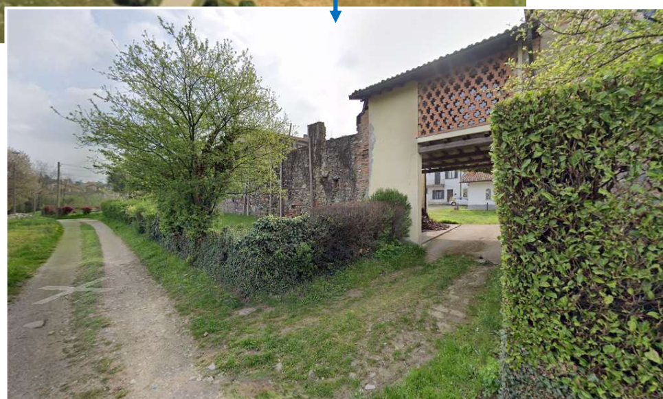
Figura 13 - Come appare oggi l'entrata di Cascina Magritto.
