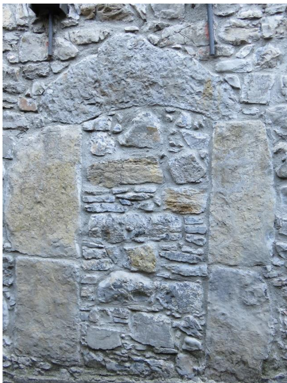
Chignolo, un bell'esempio di architrave medievale monolitico ad arco
