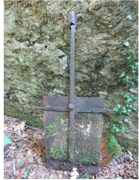
Capiretti, a sinistra: esempio di paratoia con la bocca di scarico sulla seriola a monte della ruota al fine di deviare il flusso dell'acqua permettendo l'eventuale manutenzione della ruota e dei meccanismi. A destra una chiusa di metallo.
