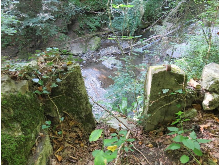
Capiretti, a sinistra: esempio di paratoia con la bocca di scarico sulla seriola a monte della ruota al fine di deviare il flusso dell'acqua permettendo l'eventuale manutenzione della ruota e dei meccanismi. A destra una chiusa di metallo.
