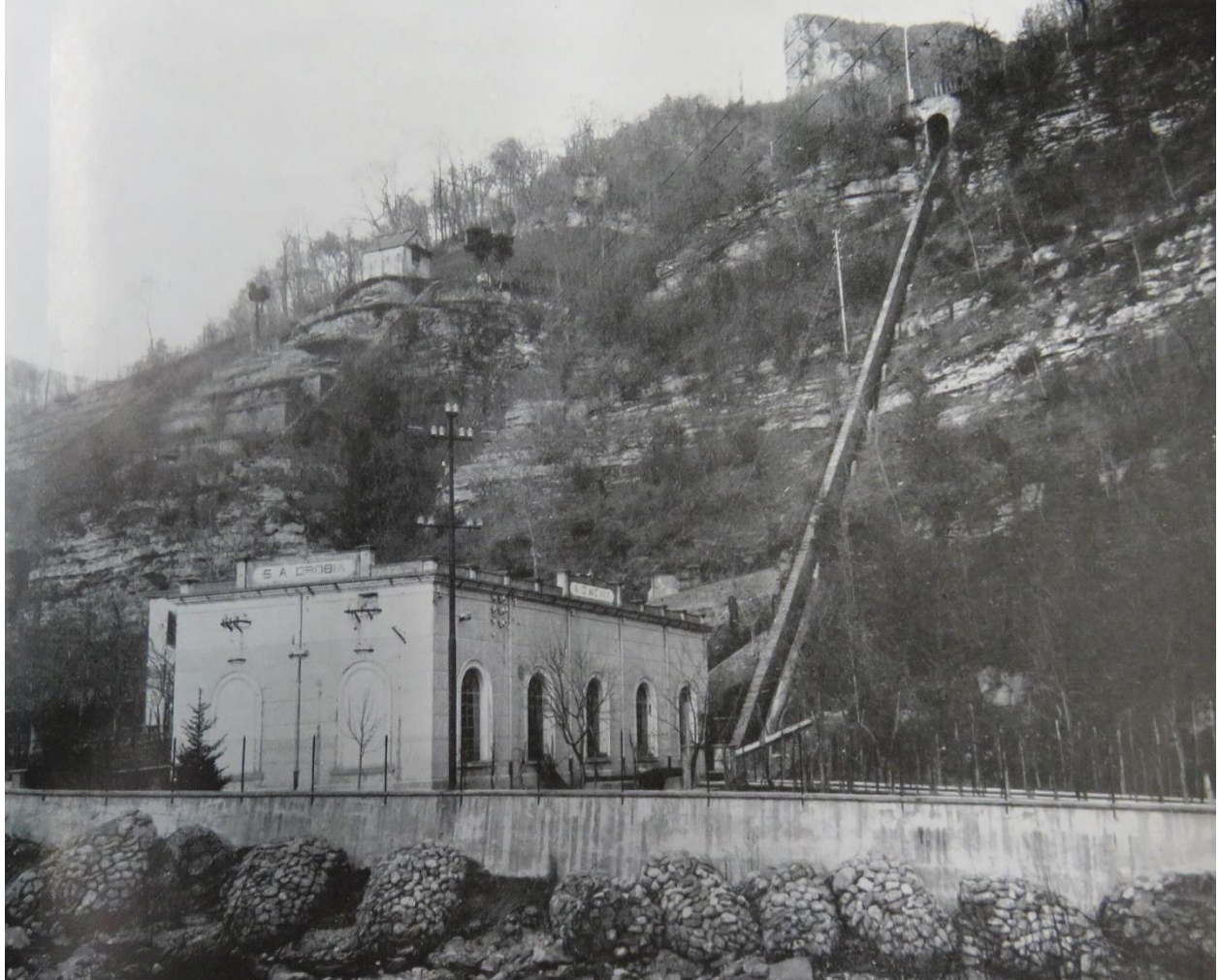
Centrale idroelettrica di Locatello
