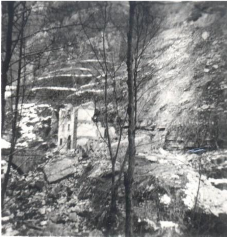
Foto scattata nel 1961 poco dopo la frana che distrugge la casa e l'antico mulino sopra il ponte tra Casabelli e Chignolo.
