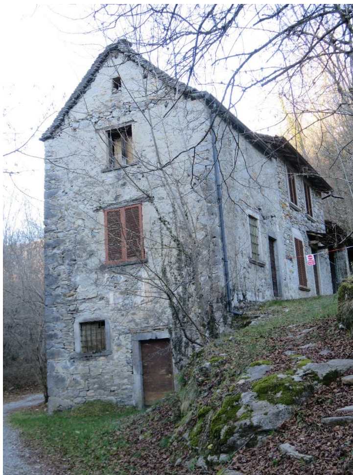
Antico edificio di Cafelice
