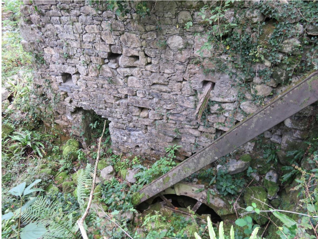
Tra le rovine è la vegetazione invadente si distingue ancora la ruota e il canale d'alimentazione della fucina in contrada Cafrago.
