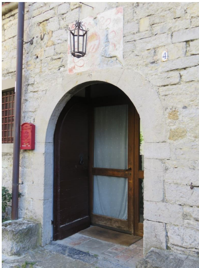
Entrata dell'antica casa Arrigoni in contrada Botta di Locatello
